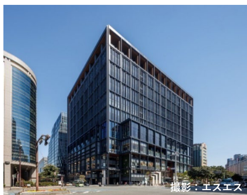
2025年4月24日にグランドオープンしたワンビル
